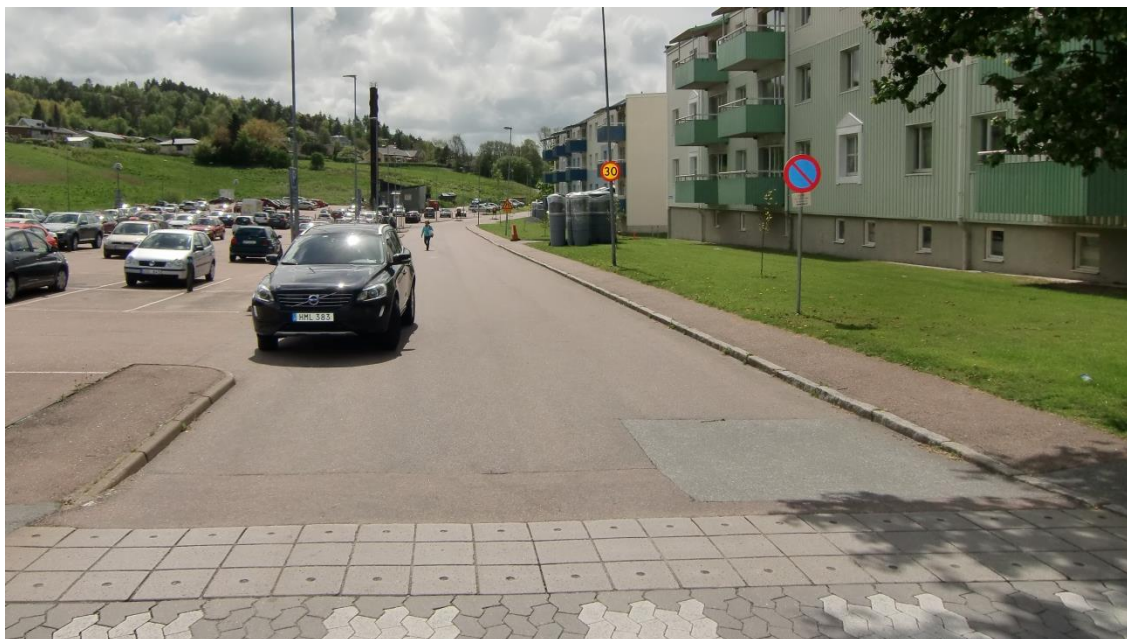
Figur 26. Klorvägen i Bohus behöver en GC-väg mot skolan.
