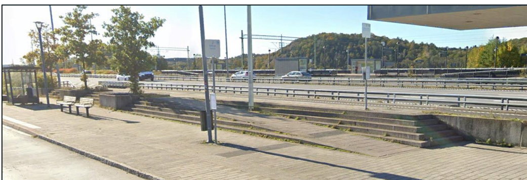
Figur 5. Befintliga trappor och ramp.
