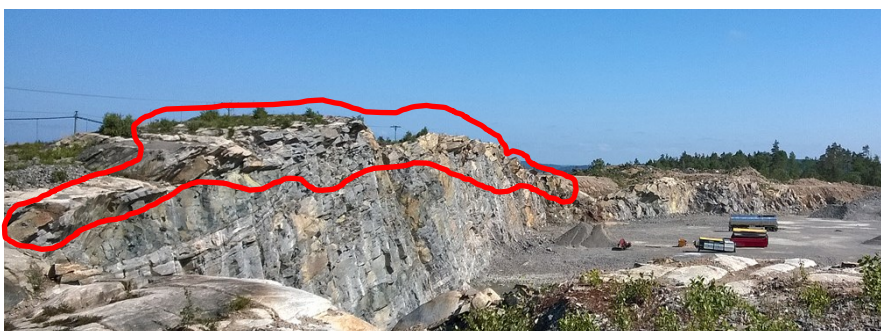
Figur 4. Uppsprucket berg med sprängskador. Berget är blockigt främst i överkant och i behov av skrotning.
