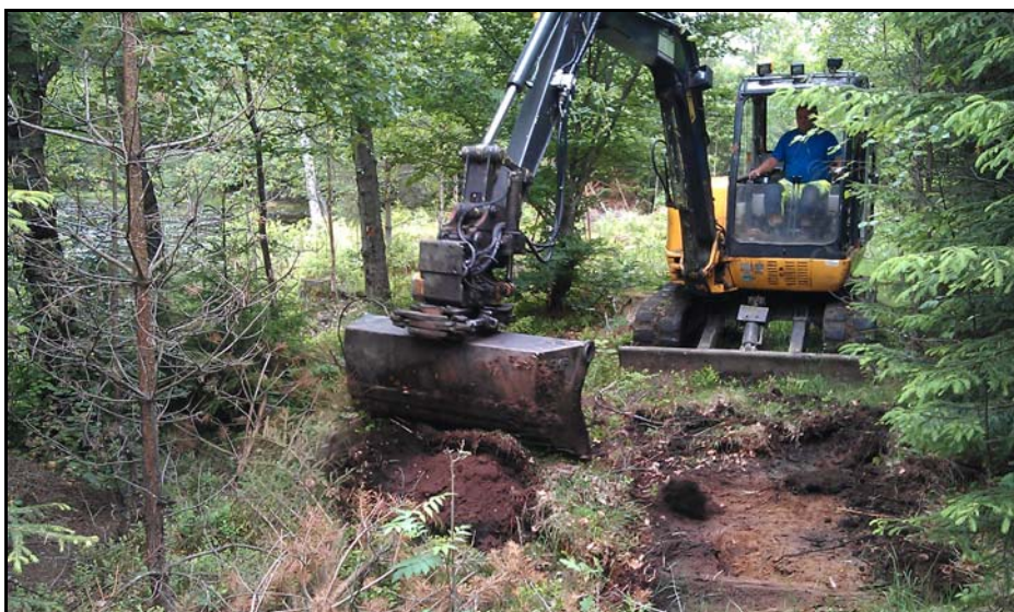
Foto som visar schaktningsarbete
