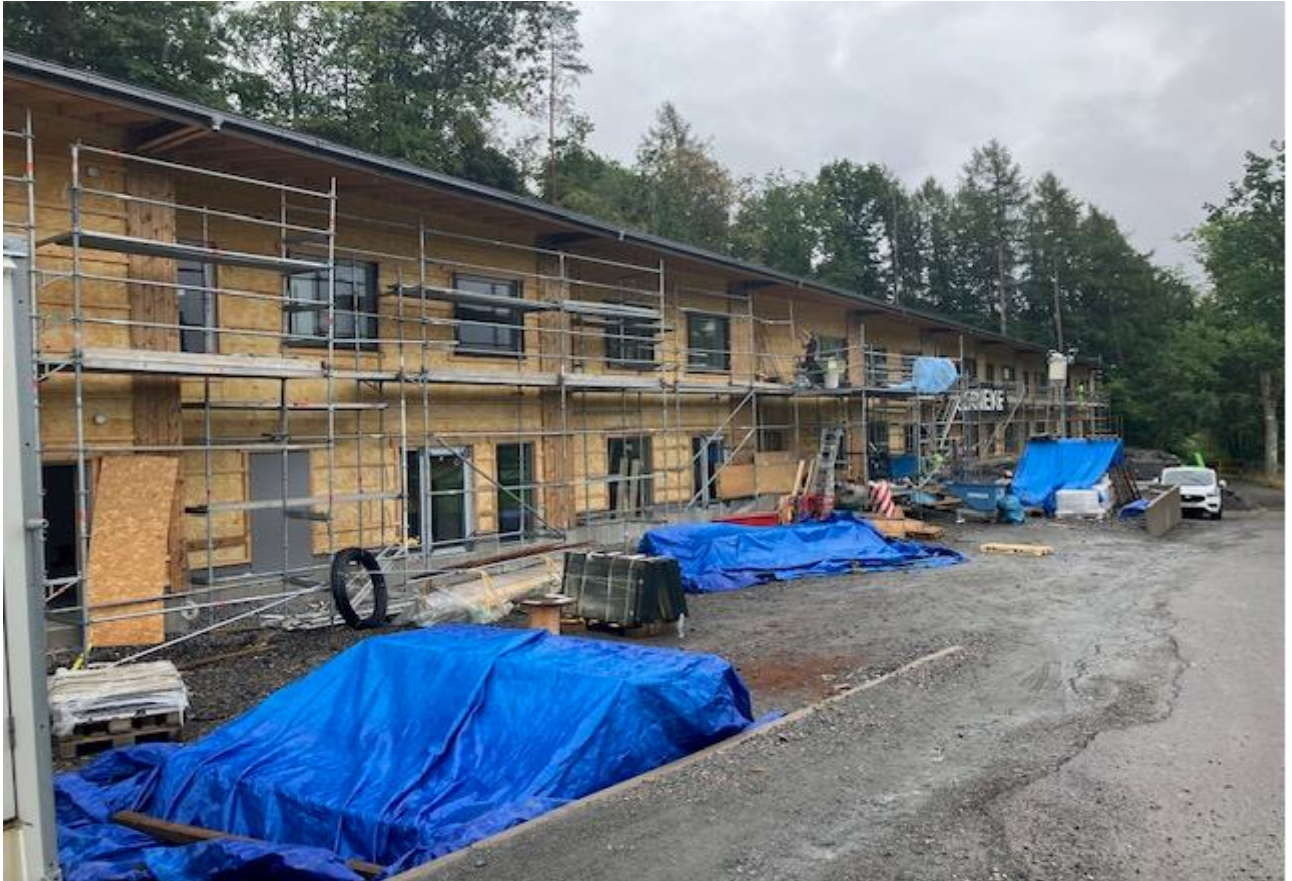
Det nya serviceboendet som ska stå klart i november 2024. Foto: Glenn Andersson
