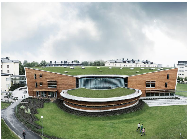
Byggnad med grönt tak, källa Vegtech
