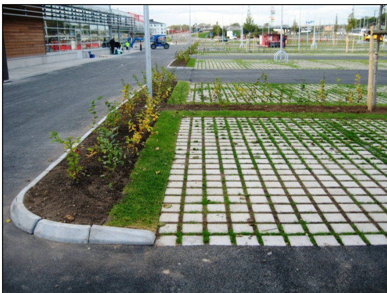
Parkeringsyta med genomsläpplig beläggning
