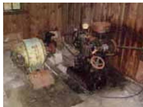
*Inredningen i Älghults maskinbus är intakt bevarad med en likströmgenerator, en likströmsmotor, varvtalsregulator och på väggen amperemätare, knivströmbrytare och säkrings-tavla. Se också bild i inledningskapitlet. Foto: CD*
