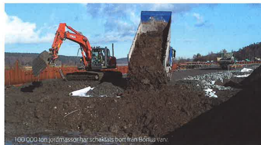
Nu är Bohus varv slutsanerat. Foto: Ale kommun
