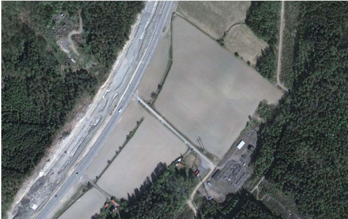
Figur 2 Flygfoto över detaljplaneområdet. Ställverket ses i högra hörnet av bilden.
